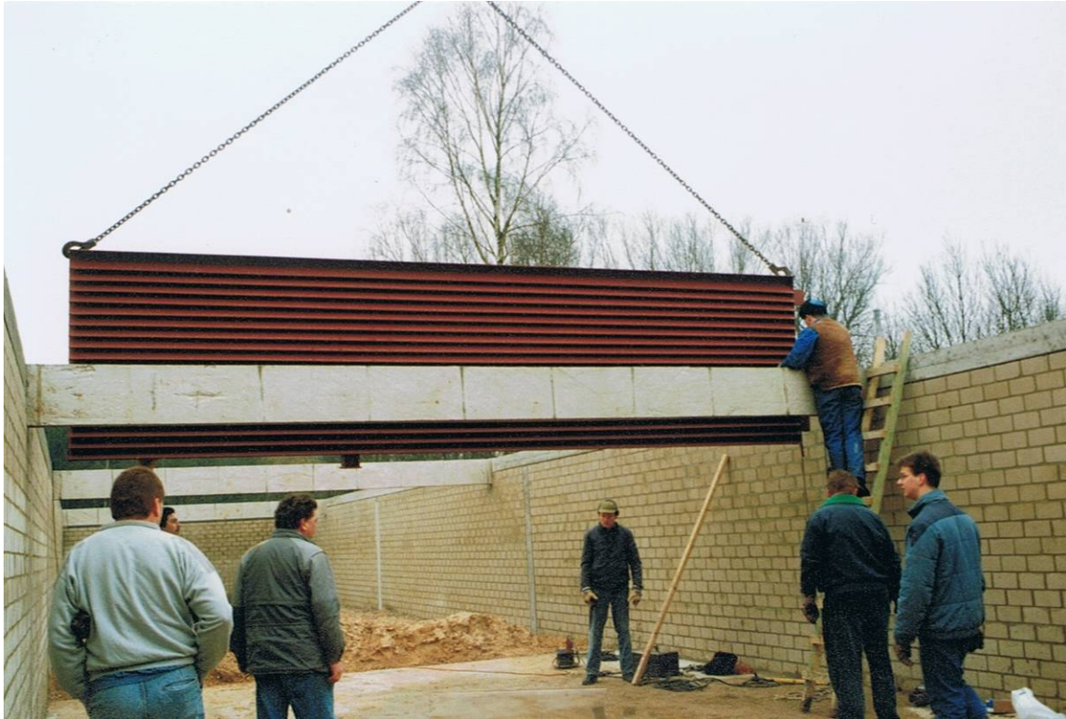
Die Kugelfänge werden mit dem Kran eingebracht.
