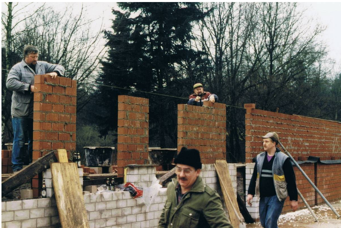
Die ersten Mauern stehen.
