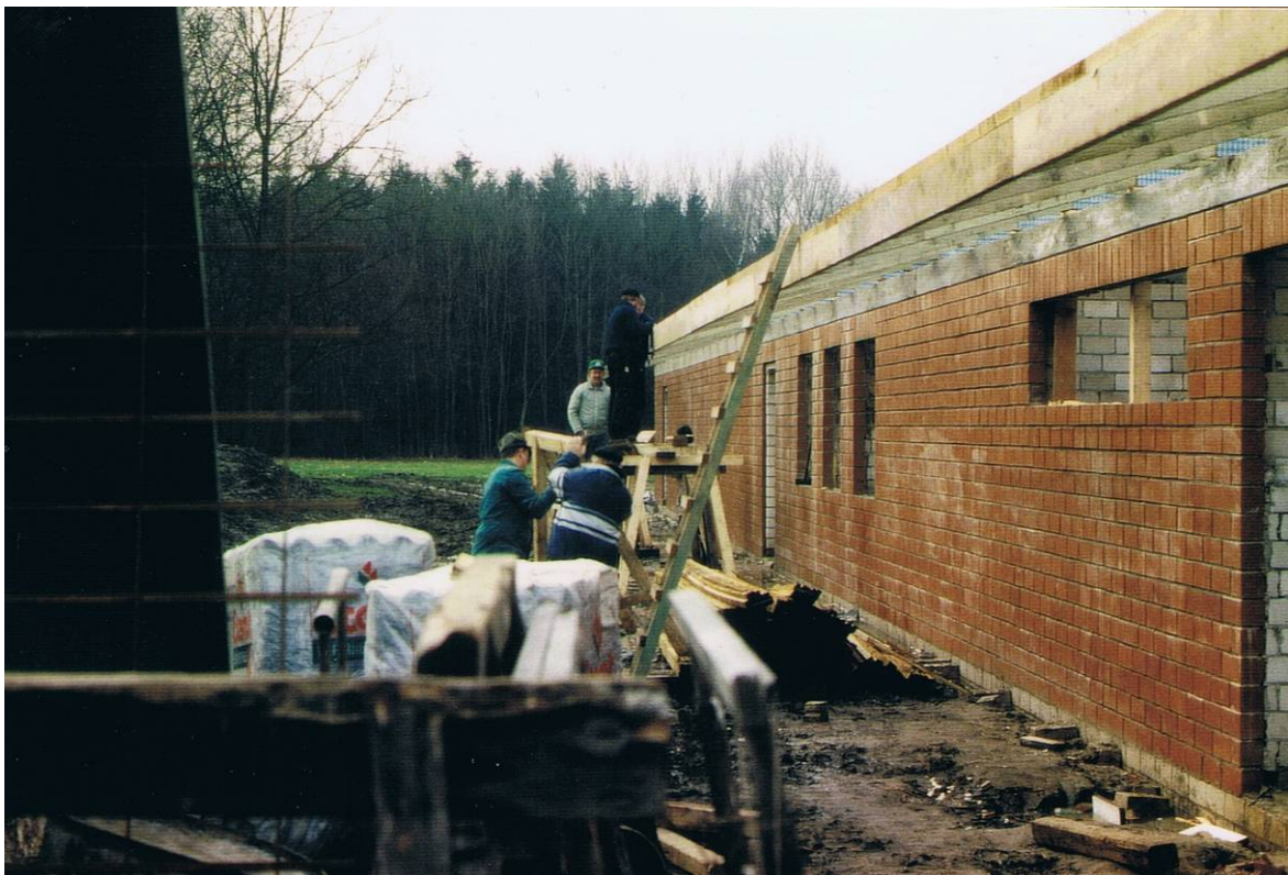
Die Maurerarbeiten sind beendet. Das Dach wird aufgebracht.
