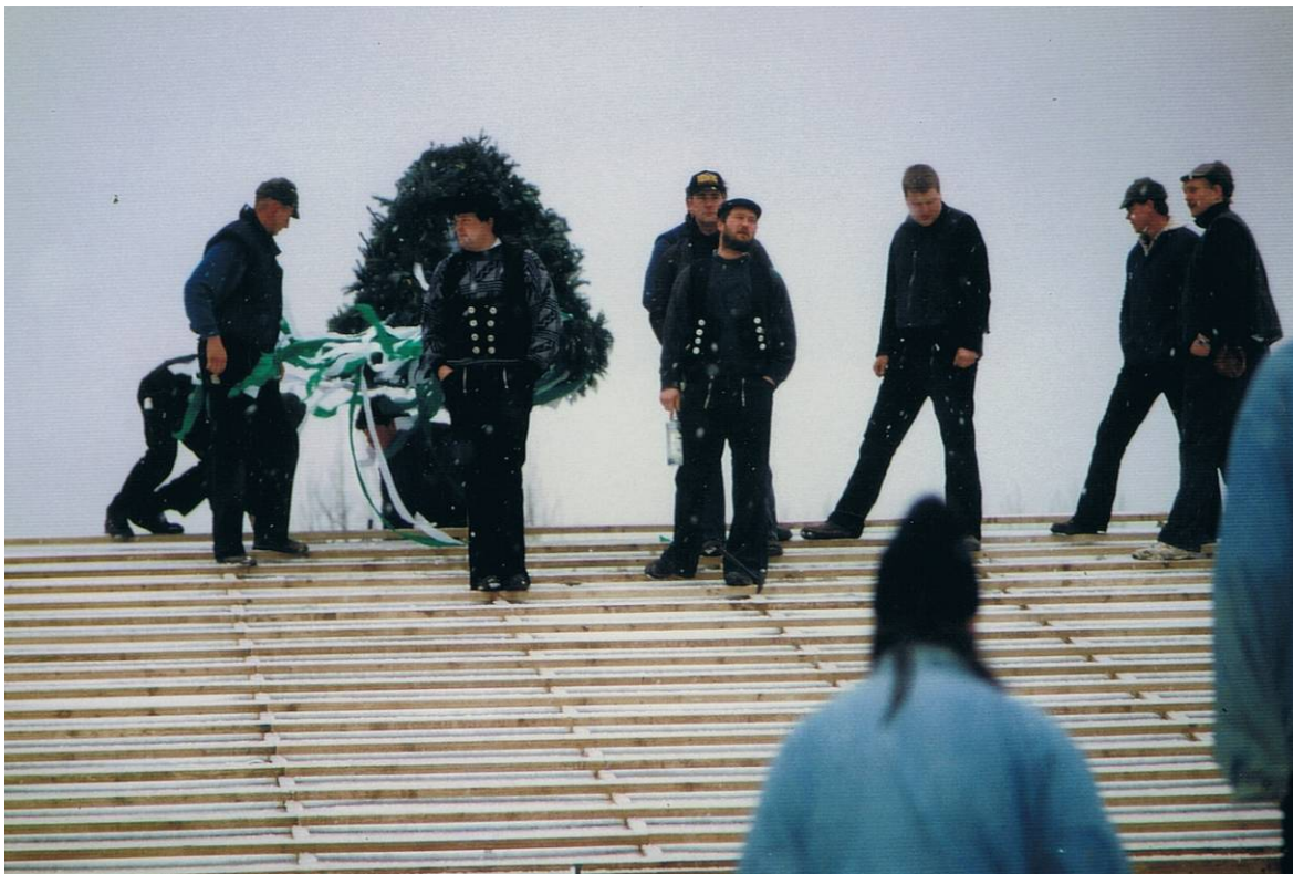
Die Bänder des Richtkranzes flattern im Wind. Den Richtspruch hält Zimmermeister Dietmar Kröger.
