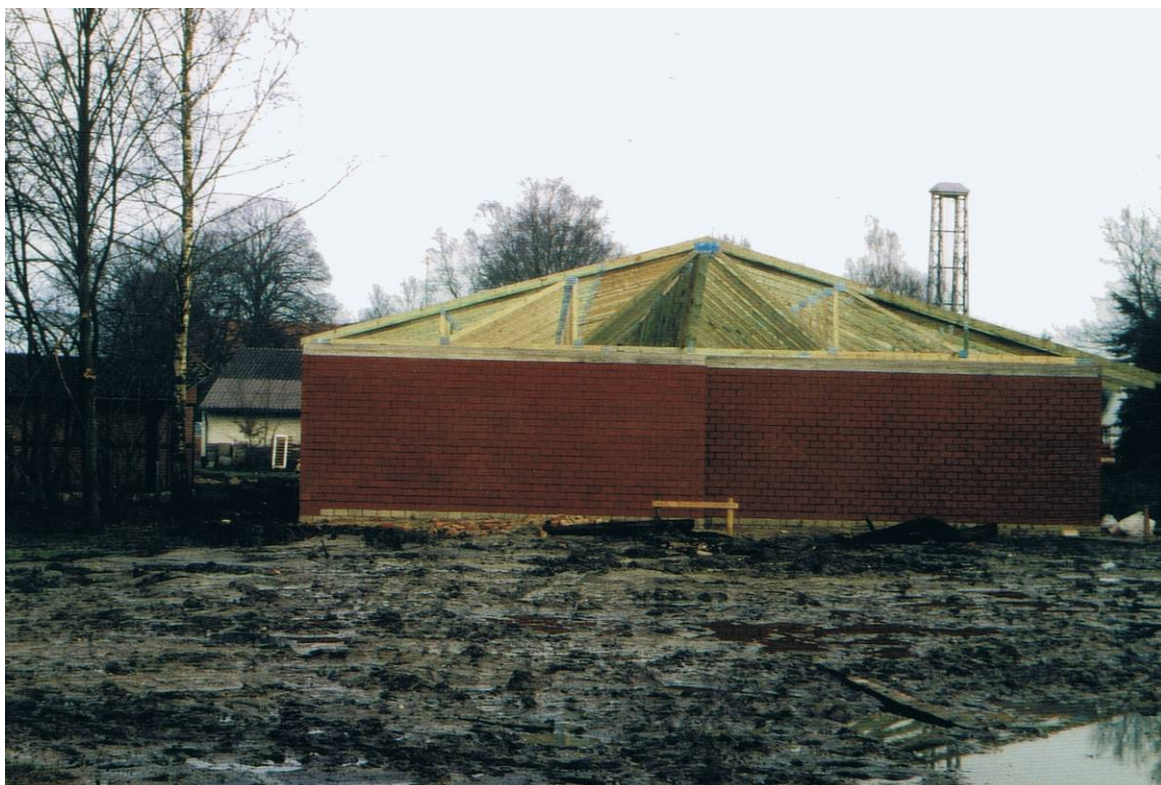
Der Dachstuhl ist fertig.
