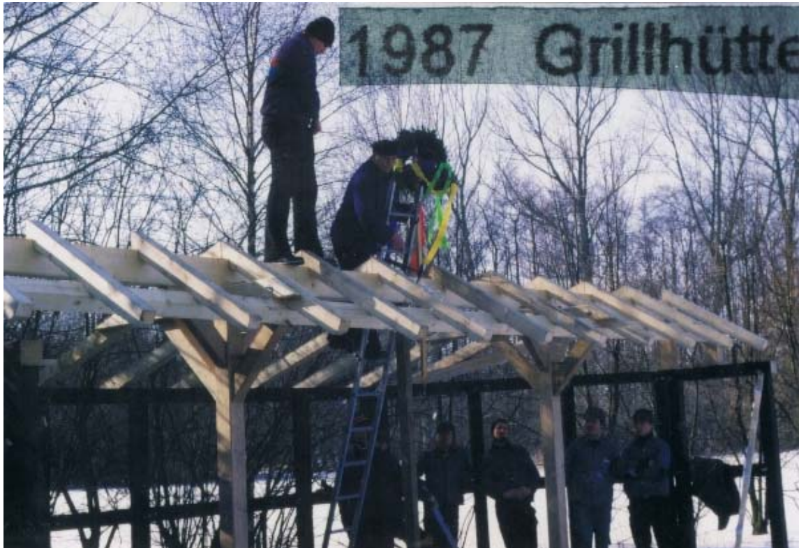
07. März 1987 - Der Richtkranz über der Grillhütte ist angebracht.
