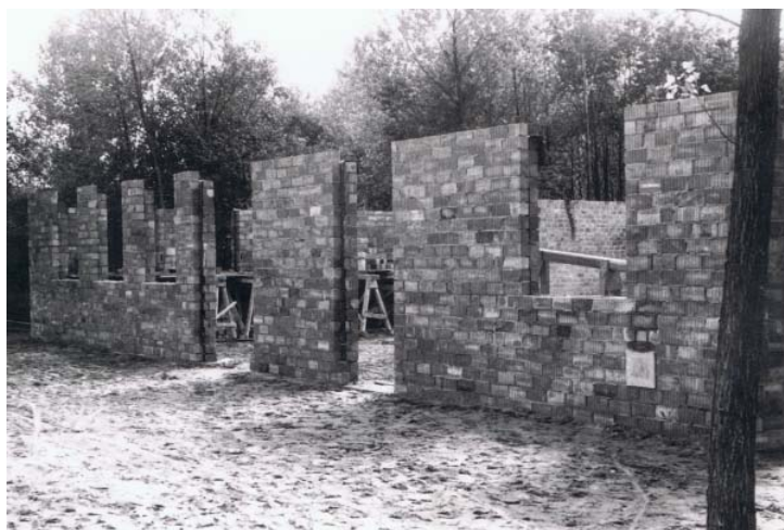
Die ersten Grundmauern stehen
