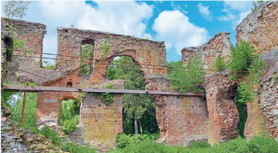
Die Burgruine mit dem nachträglich zur Sicherung angebrachte „Stahlkorsett“
