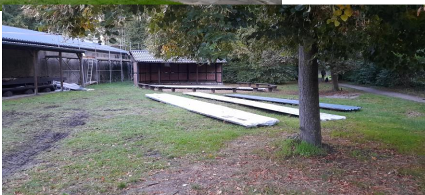
Die neuen Trapez-Bleche liegen bereit
