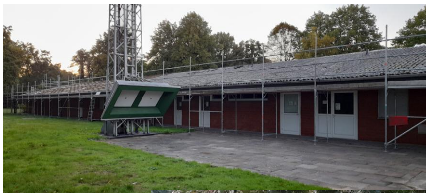
Das Schützenhaus ist „engerüstet“
